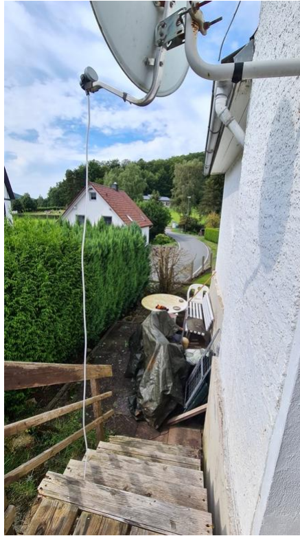
Außentreppe zum Freisitz, EG re.
