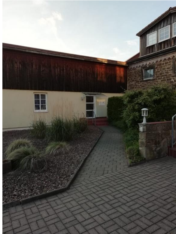
Nebengebäude mit der Wohnung
