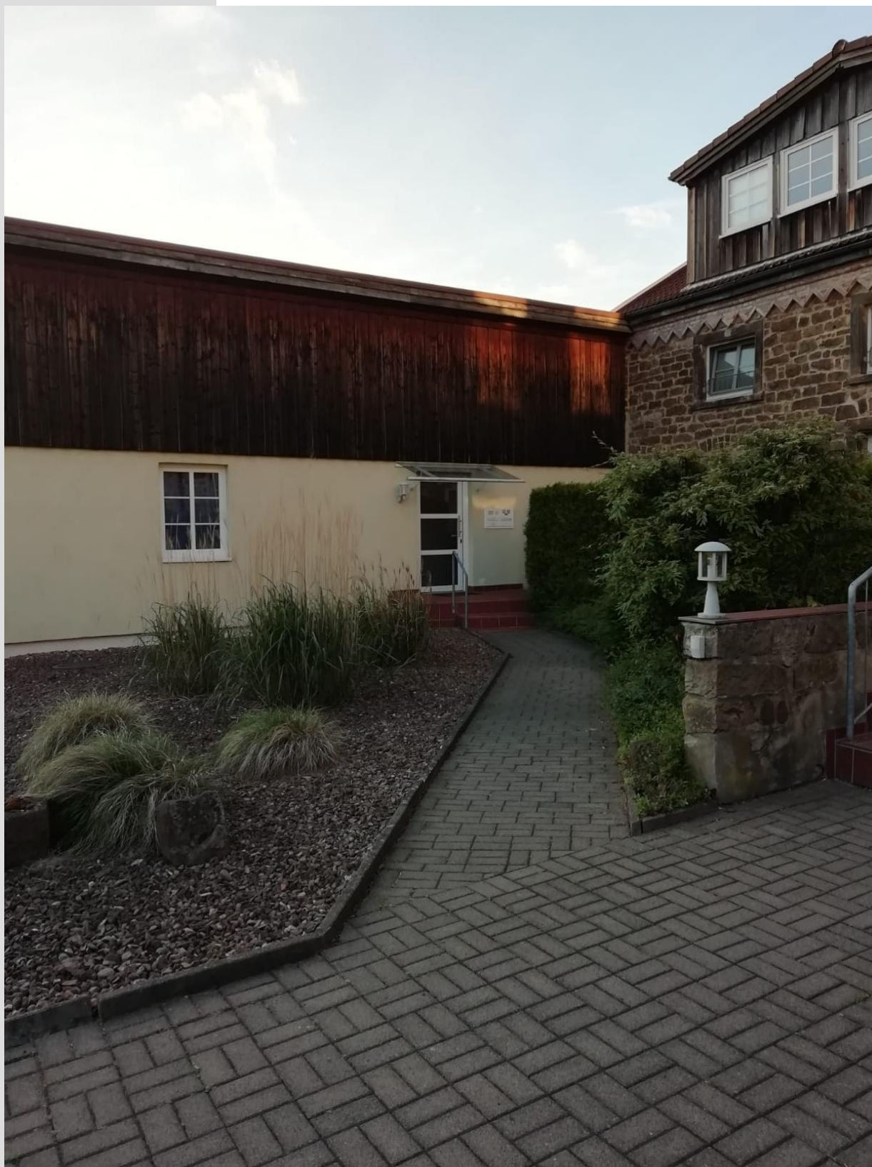
Nebengebäude mit der Wohnung
