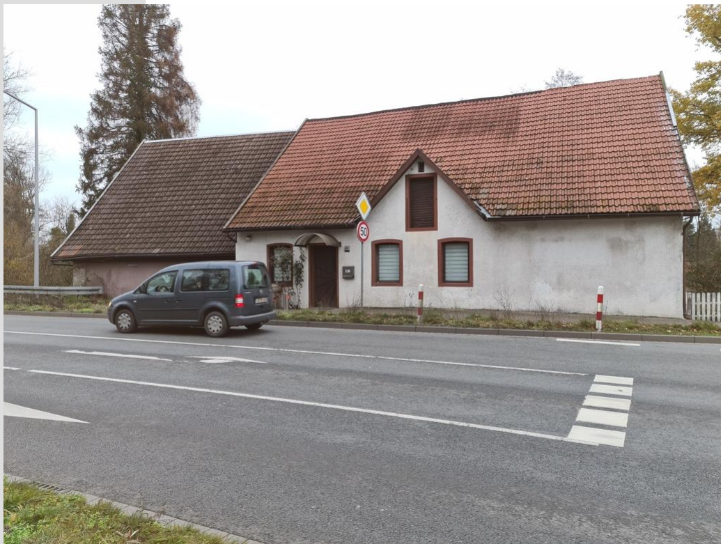
Ansicht von der Bielefelder Straße
