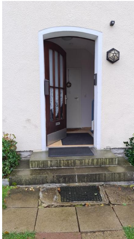
Außenansicht Eingang zum OG + DG
